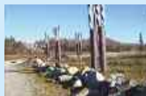
Caloducs (heat pipes) le long du pipeline de l'Alaska.
